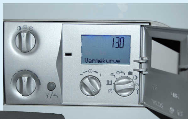
Eksempler på vejrkompen-seringsanlæg placeret i eller ved varmekilden
