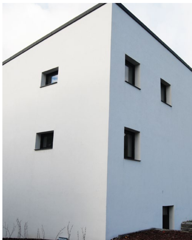
Udvendig facadeisolering med puds på ydervæg af massive letklinkerblokke på ejendom fra 1953
