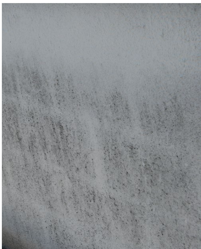
Konturerne af letklinkerblokkene anes på de beskidte facader på ejendom fra 1953
