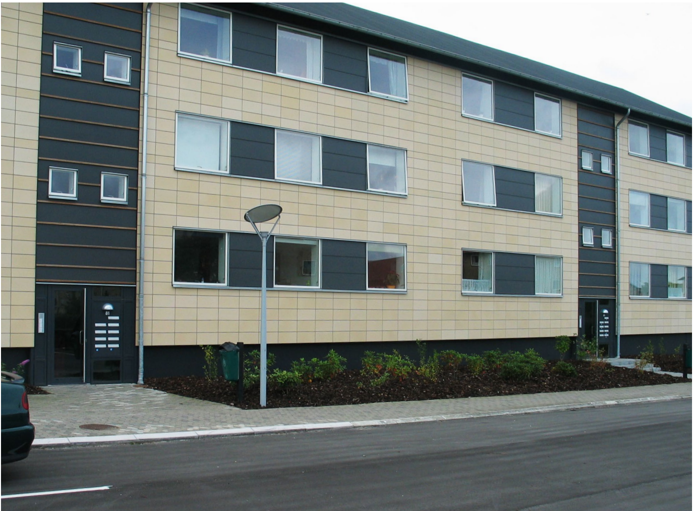
Udvendig facadeisolering med skærmtegl/fibercementplader
