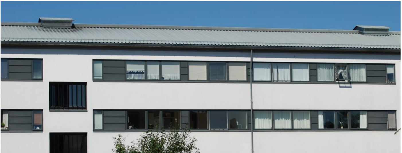
Udvendig facadeisolering med puds
