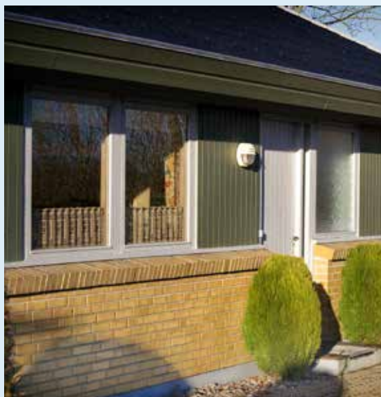
Hus med lette træpartier mellem vinduerne.
